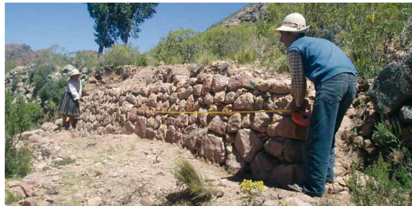
Construyendo terrazas para la conservación del suelo.
